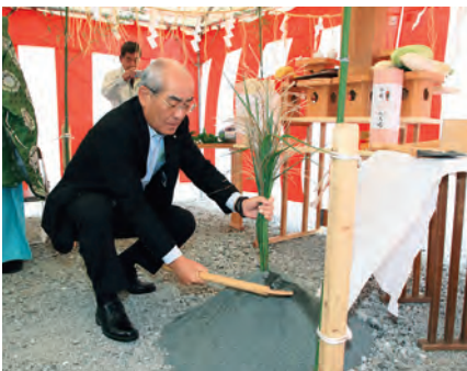
▲工事の安全を祈願し、起工式で鎌入れをする田村町長
