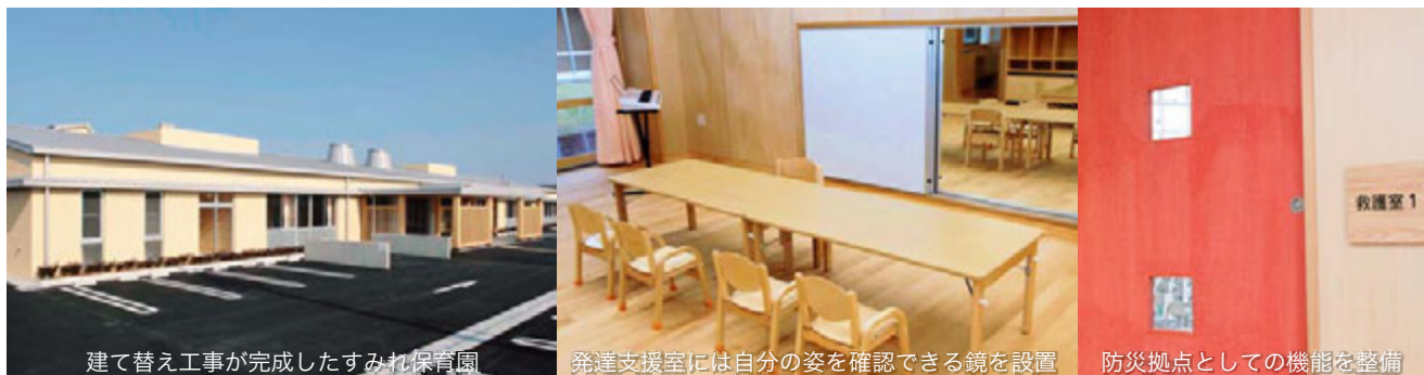
建て替え工事が完成したすみれ保育園
