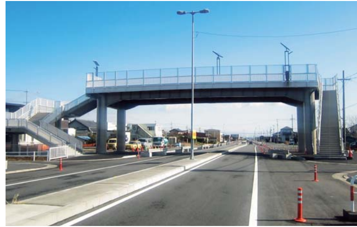
津波避難タワーB (住吉3254-20) 床面積 255平方メートル 収容人数 約500人 地盤高(海拔) 3.0メートル デッキ高 7.4メートル(地上から) 想定浸水深 4.6メートル(地上から) 工事費 約2.8億円
