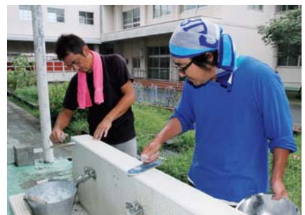
▲自彊小学校外水道のタイルの目地詰めをする組合員
