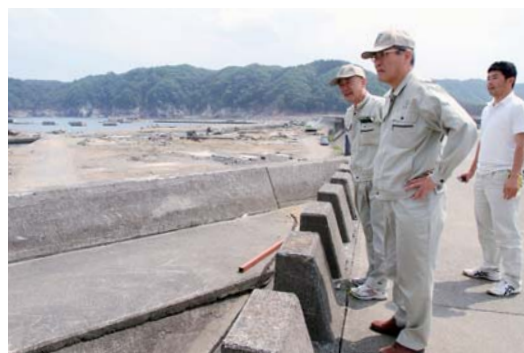
▲津波対策に向けて津波で砕けた宮古市田老地区の「万里の長城」と呼ばれる防潮堤を視察する田村町長
