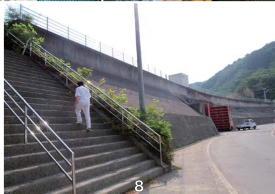
1 津波で打ちあげられた大型船(釜石港) 2 被害を最小限に食い止めた普代水門(普代村) 3 「万里の長城」と呼ばれる田老地区の防潮堤(宮古市) 4 普代村職員から説明を受ける田村町長と町職員 5 津波により崩れた湾口防波堤(釜石市) 6 住民から被災状況を聞く田村町長(陸前高田市) 7 津波で砕けた田老地区の防潮堤を見る町職員(宮古市) 8 住民の命財産を守った高さ15.5mの太田名部防潮堤(普代村)
