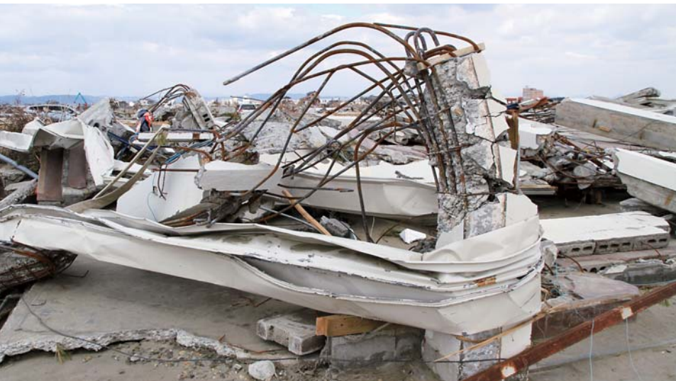
▲根元から折れ曲がった鉄筋コンクリートの柱。津波の破壊力を感じさせる
