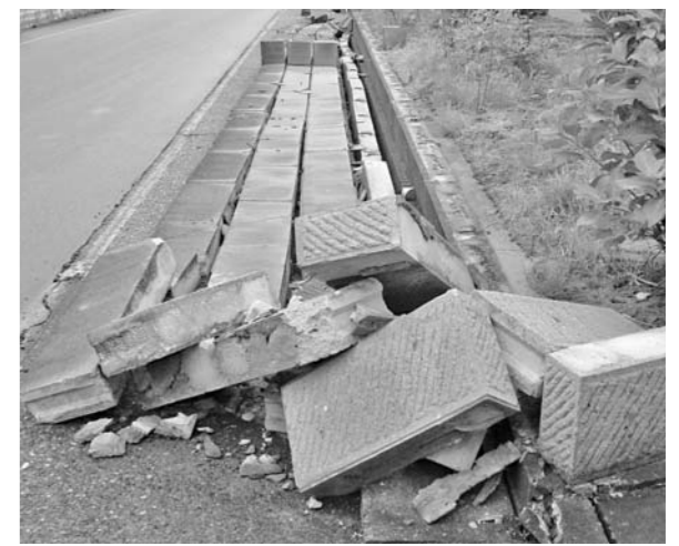
写真：新潟県中越沖地震被災地 提供：静岡県建築安全推進室
