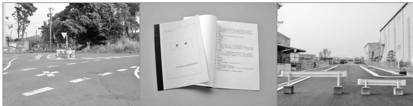
今年度から工事を開始する榛南広域農道
