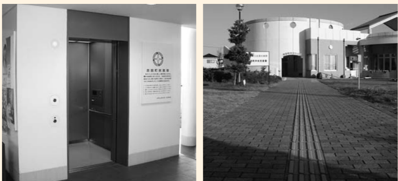
車いす対応のエレベーター(町立図書館) 玄関までの誘導点字ブロック(中央児童館)
