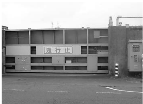
第1・2・4・6陸間では、遠隔操作化の平成21年度完成を目指し工事が進められています。
