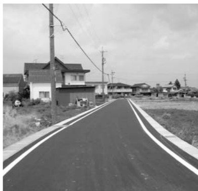
改良工事が完了した西川原北原線
