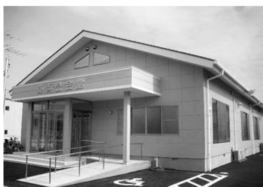
完成した東浜公会堂
