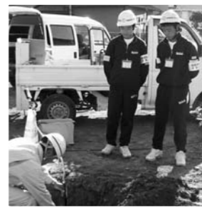
水道工事現場の確認をする増田貴文さんと和田高樹さん
