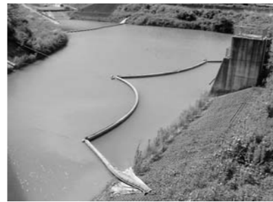
水質汚濁防止のために設置されているシルトフェンス
