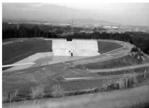
整備が完了したY-6調節池
