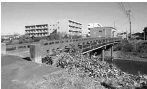
老朽化に伴い架け替え工事が実施されるお夏橋
