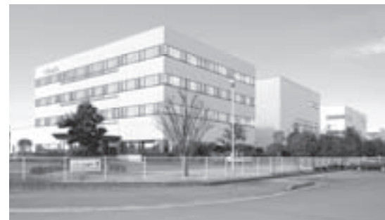
水処理施設製造会社
