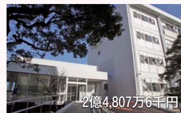
中央公民館改修 2億4,807万6千円 ▶ 中央公民館の耐震補強工事およびエレベーターの設置、トイレの洋式化などの大規模改修工事を実施
