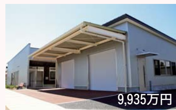
高齢者人材活用センター整備 9,935万円 ▶ 高齢者の生きがいづくりや社会参加活動を支援する施設を整備
