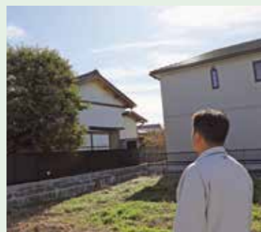
⑤屋根の状態も確認
