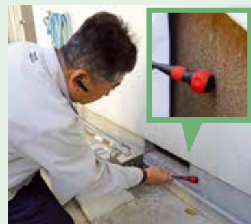
④壁や基礎に亀裂がないか確認
