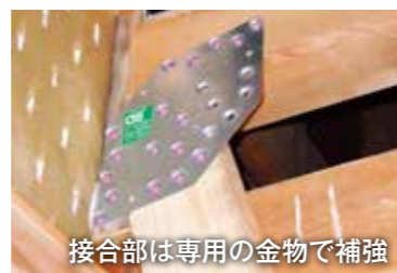
強度の強い板材を貼り、補強
