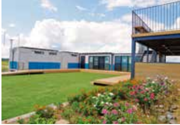
芝生エリアやデッキテラスで憩いの場も兼ねた水防センター
