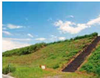
リモコン式除草刈り機で一部整備された川尻防潮堤
