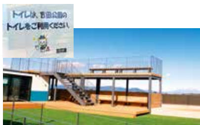
5月に完成した水防センターとトイレの案内
