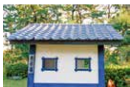
川尻大道公園内男女共用トイレ
