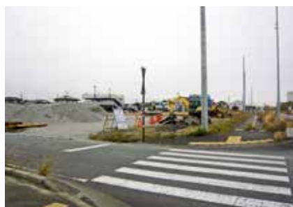
川尻地区の下水道工事現場
