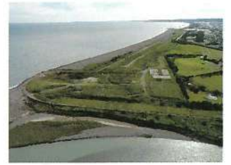
整備前(令和2年9月)
